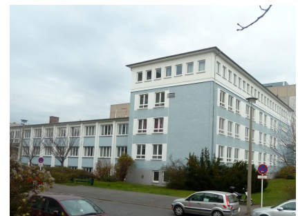
Ein Gebäude aus den 1950er-Jahren im Blockinneren
