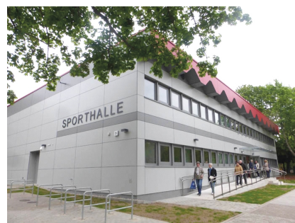
Die Sporthalle am Nibelungenpark ist komplett saniert
