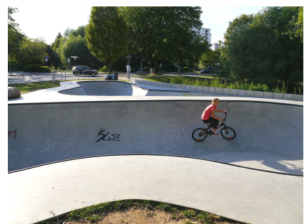
Die neuen Betonrinnen stellen hohe Anforderungen an das Können der FahrerInnen
