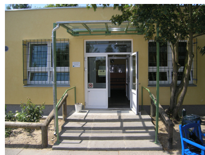
Der sanierte Eingang des Jugendtreffs "Senfte 10"
