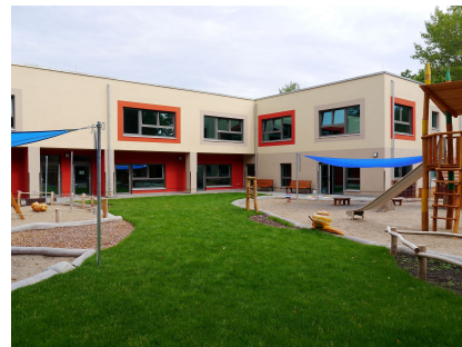
Zur neuen Kita gehört eine großzügige Freifläche
