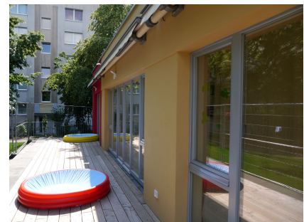
An der Gartenseite verläuft eine Sonnenterrasse
