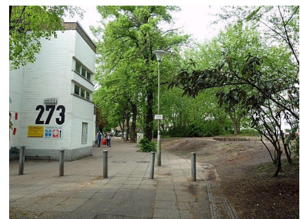
Der Zugang von der Sonnenallee vor Projektbeginn
