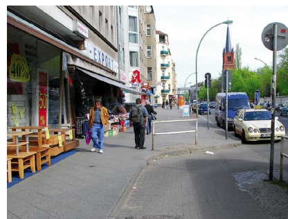
Engstellen auf dem Gehweg vor dem Umbau
