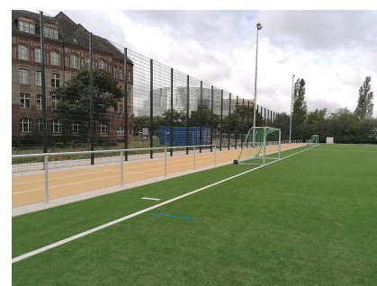
Der erneuerte Sportplatz an der ehemaligen Teske-Schule
